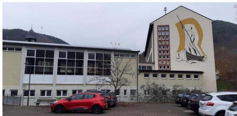
In den Jahren 2012-2014 wurden die Fenster getauscht, es wurden teilweise Dreifachverglaste Fenster eingebaut und die oberste Geschossdecke mit einer druckfesten Wärmedämmung ca. 10 cm versehen und mit einer OSB-Platte zwecks Begehrbarkeit abgedeckt.
