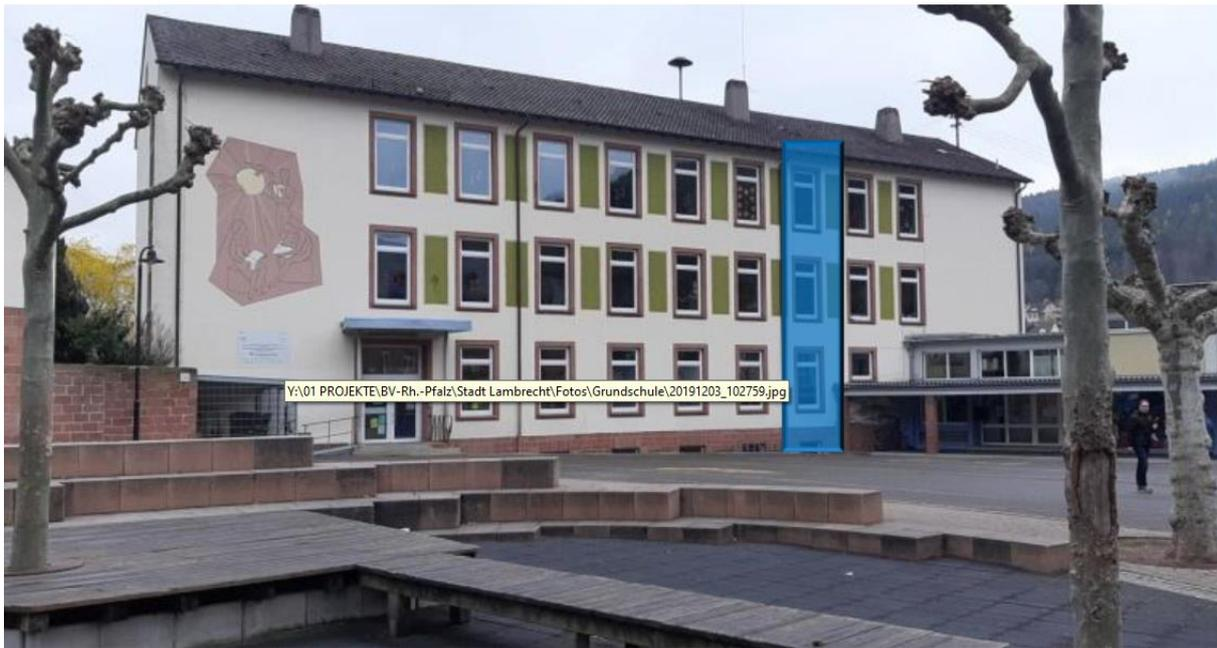
Abbildung 24: Mögliche Anordnung des Aufzugs an der Außenfassade
